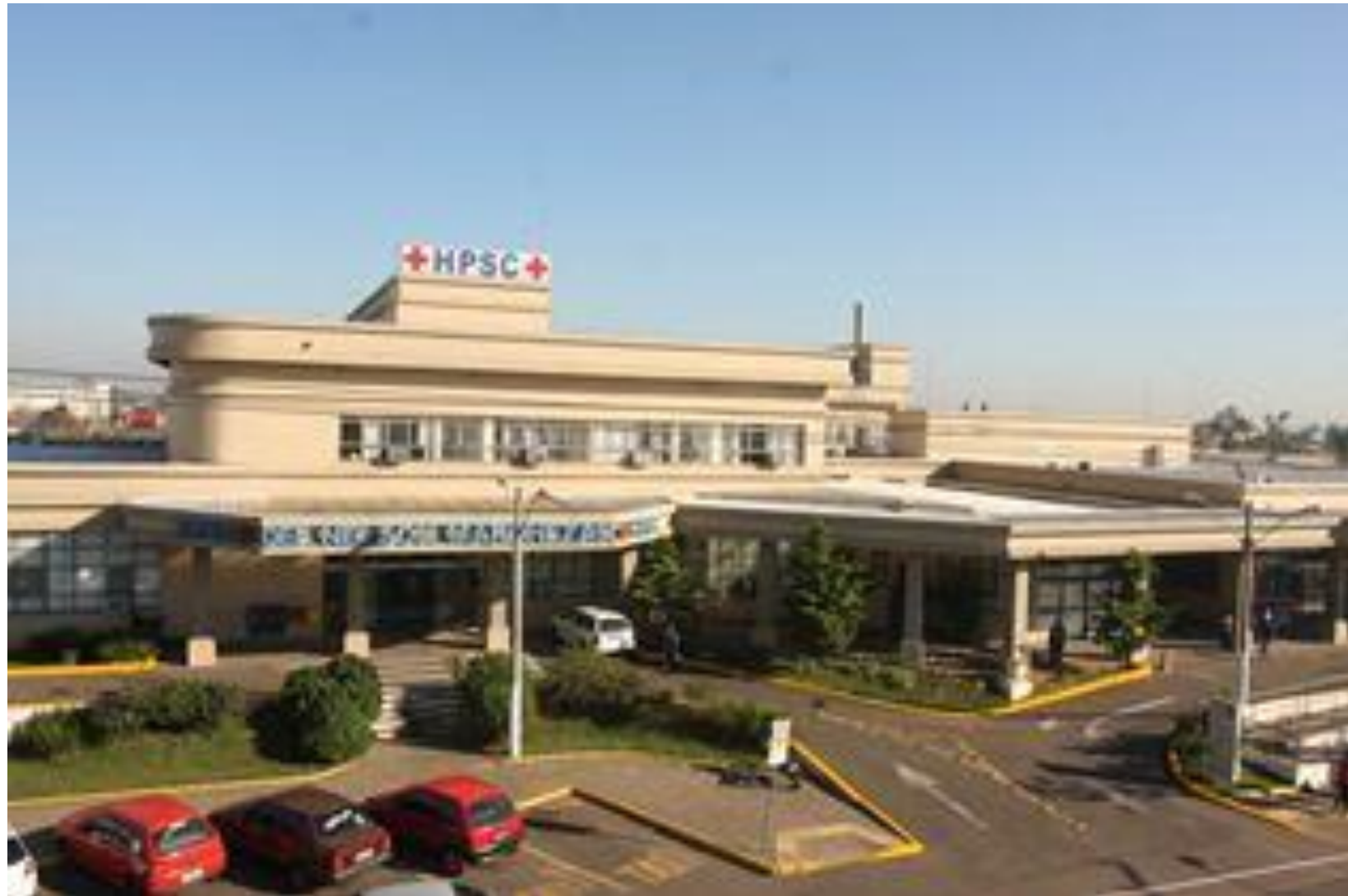
Figura 1 – Hospital de Pronto-socorro de Canoas;
